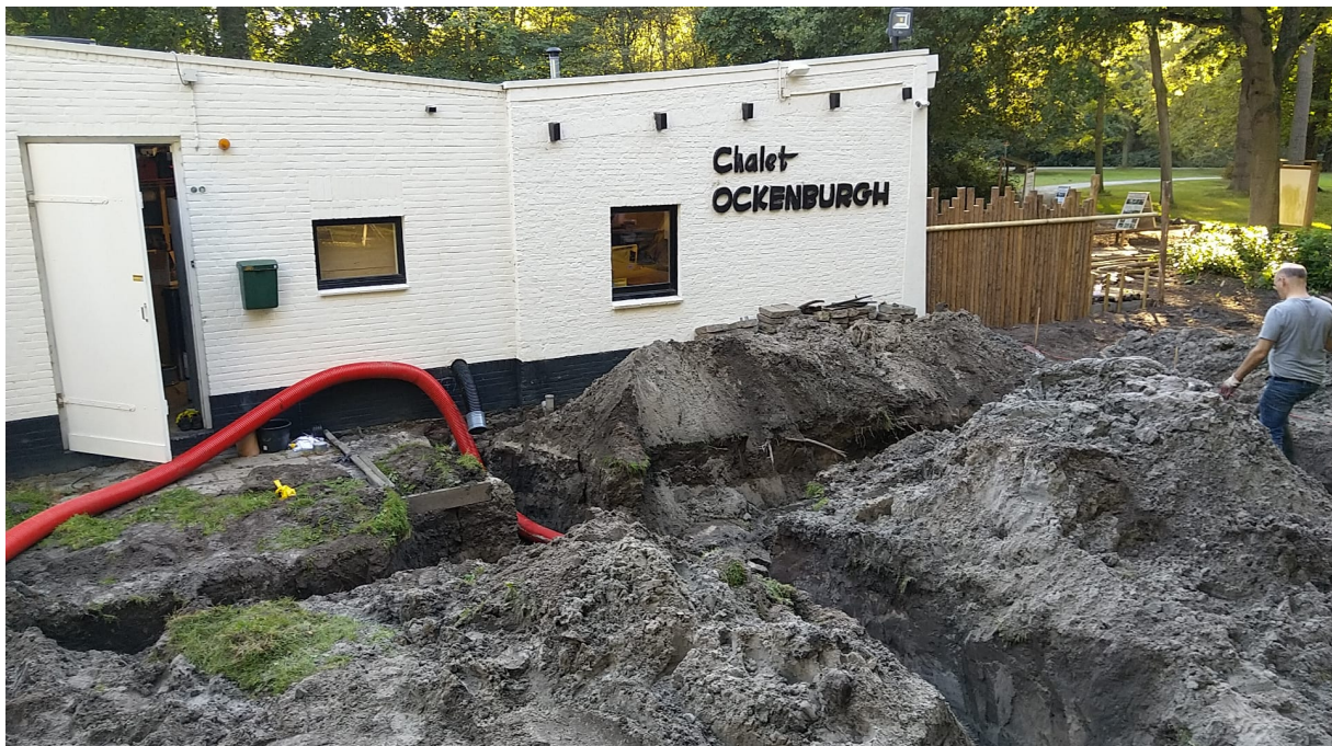
Aanleg van een aardwarmtewisselaar op 1.7 meter diepte naast Chalet Ockenburg.
