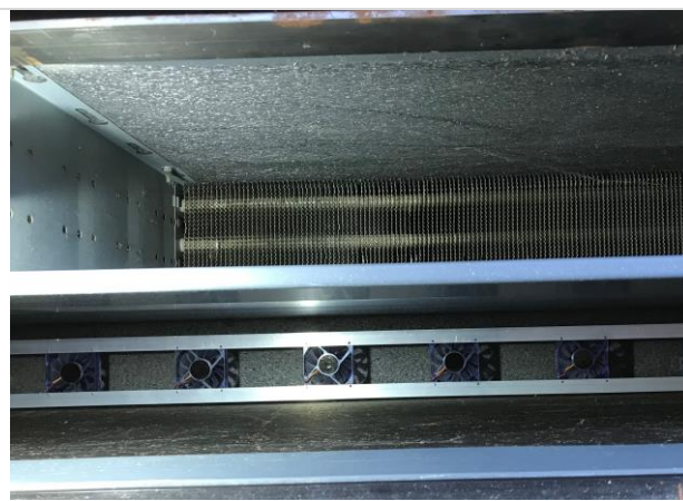
Foto 6: Frame gereed voor onder de radiator
